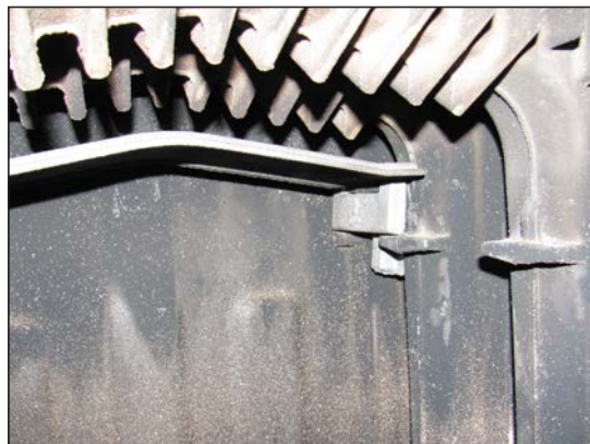
Fig. 3 Primer deflector y distanciador trasero
