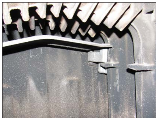
Fig. 3 1° deflettore e distanziale posteriore
