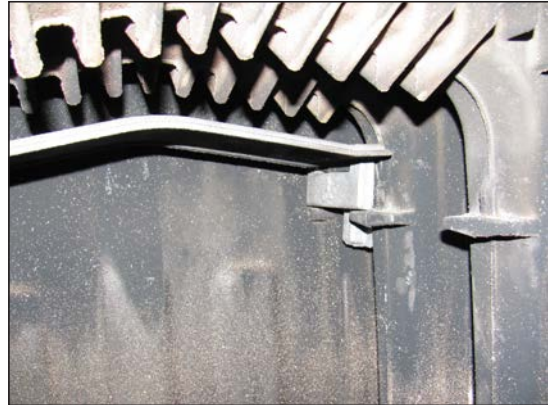
Рис. 3 1-й дефлектор с задними боковыми опорами
