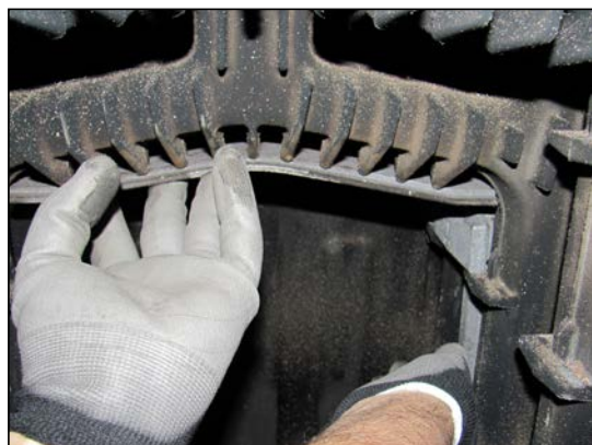
Fig. 5 Segundo deflector y distanciador delantero
