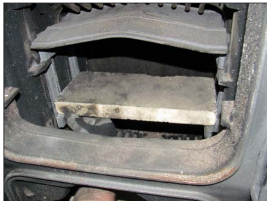
Fig. 7 Montaggio delle tavelle di cemento
