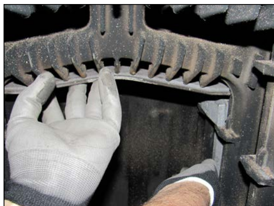
Fig. 5 2° deflettore e distanziale anteriore
