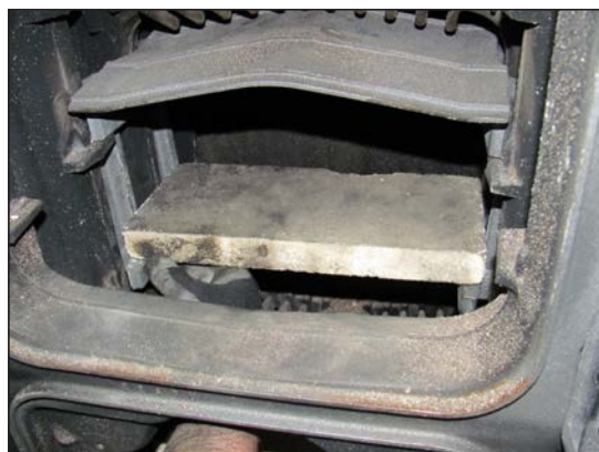
Fig. 7 Montaje de los ladrillos de cemento
